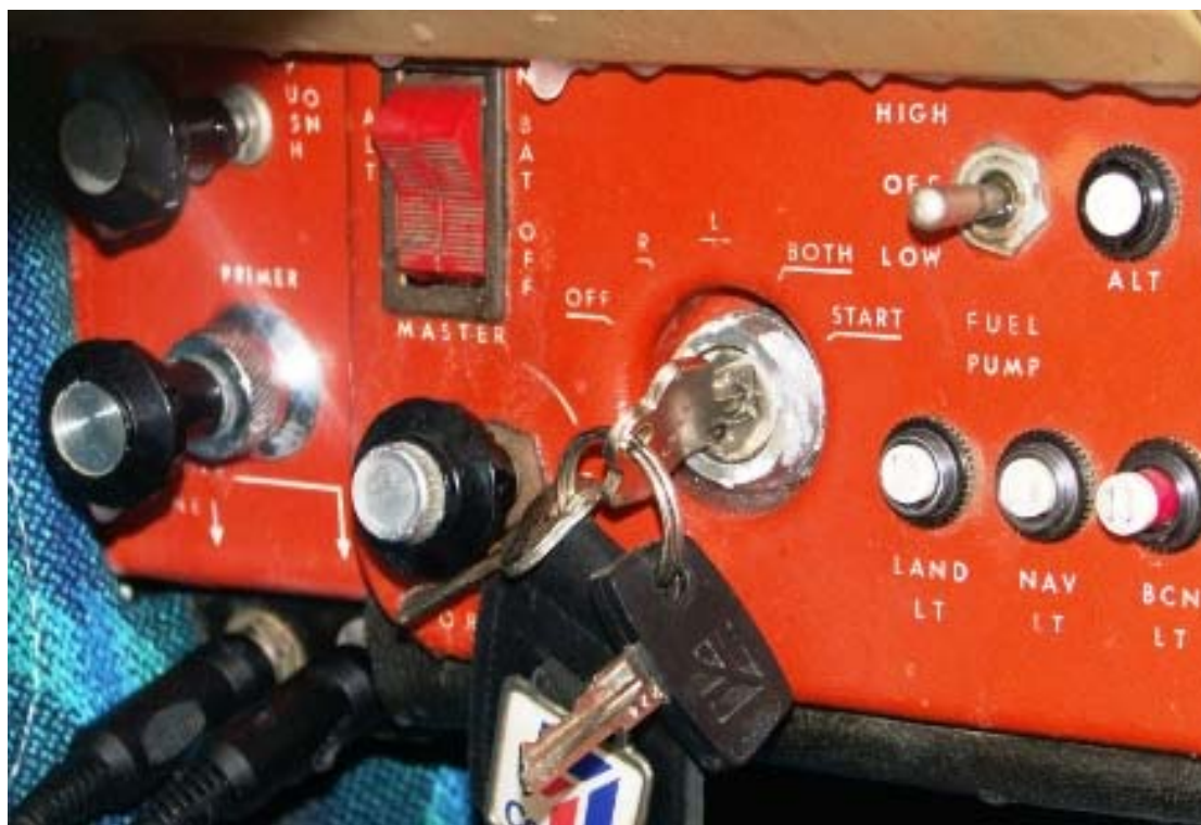
Fot. 15 – Przełącznik iskrowników w położeniu po lądowaniu awaryjnym ustawiony na „lewy + prawy” (BOTH).
